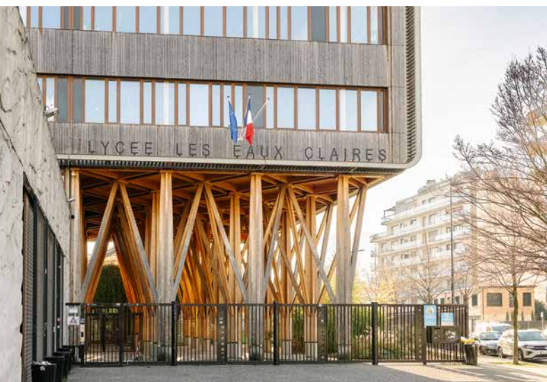
Le lycée des Eaux-Clares
